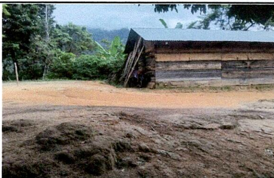
Foto 6: Piso de tierra en mal estado
