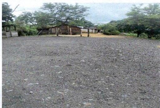
Foto 5: Aula de madera dañada
